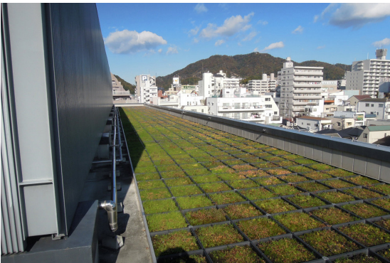
屋上緑化の例
