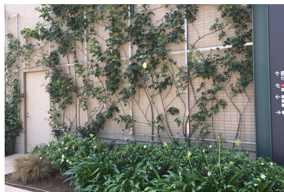
補助資材を使用した壁面緑化の例
