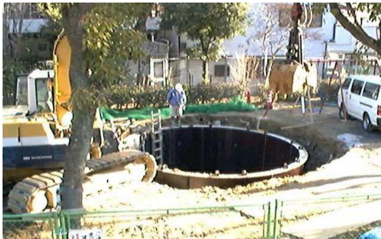
図 公園での耐震性防火水槽の設置
