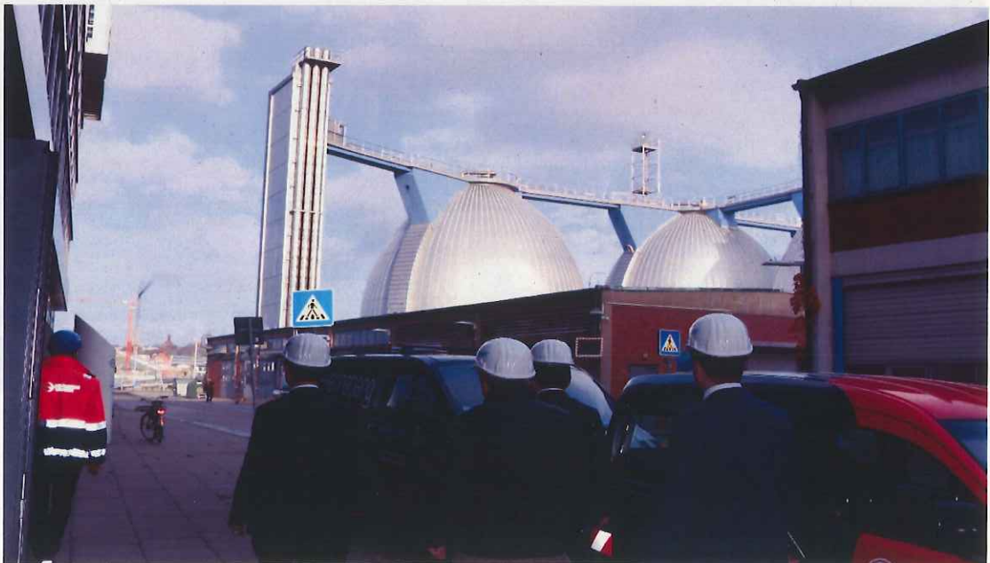
(巨大な卵型の施設が下水の発酵施設)
