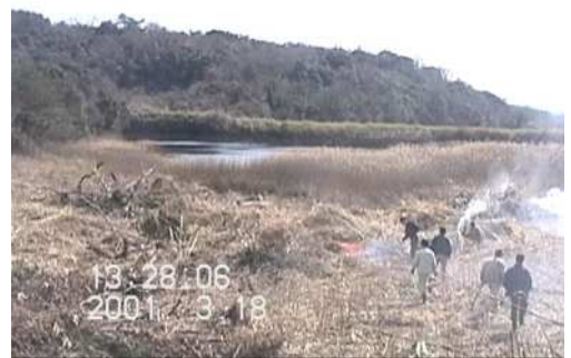
重機で雑草を除去・整地した
