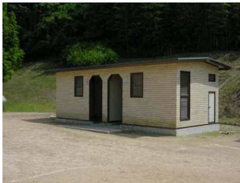
トイレの整備（他地区事例）
