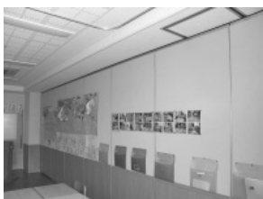
移動可能な間仕切り壁
